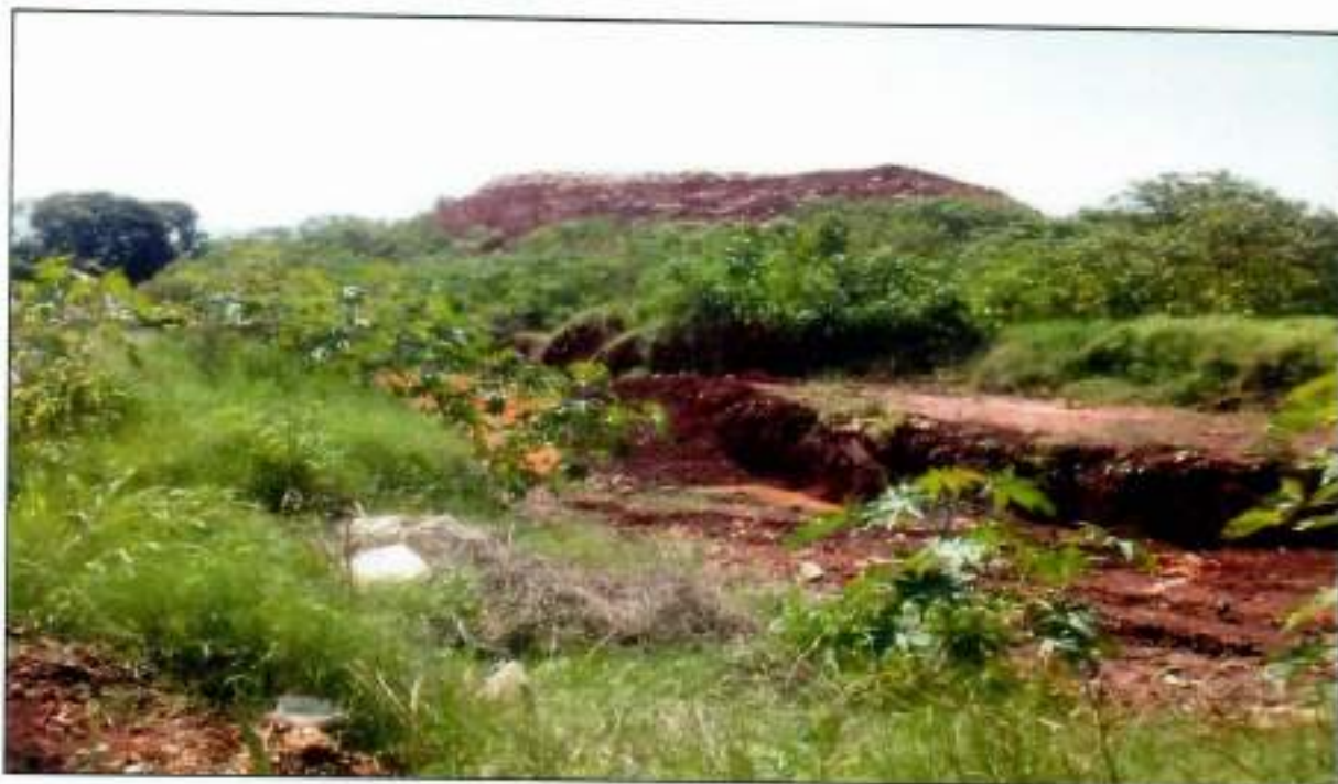
Figura 36: Imagem da célula do aterro municipal - CIGRES esgotada.
